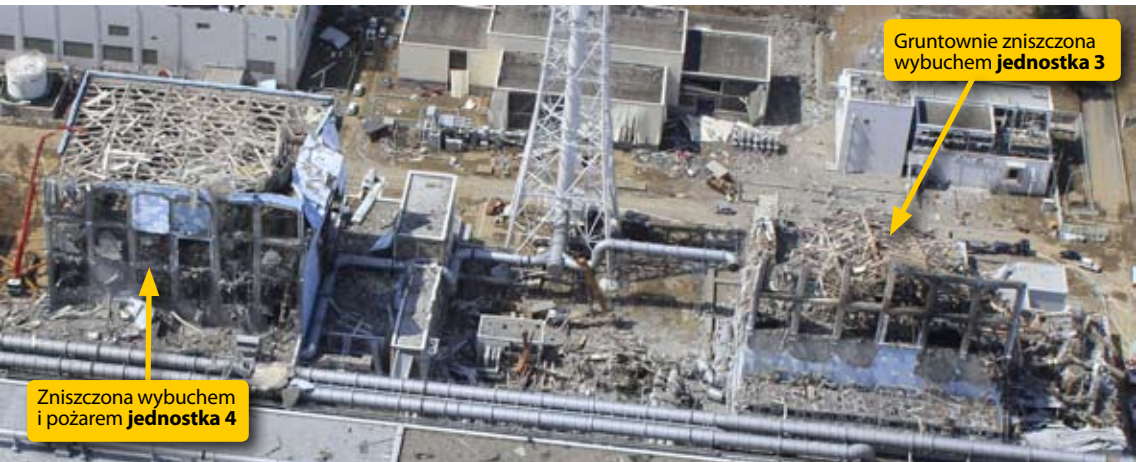
Reaktor nr 2: stopnienie paliwa, wybuch wodoru
