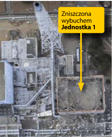
Reaktor nr 1: stopnienie paliwa, wybuch wodoru
